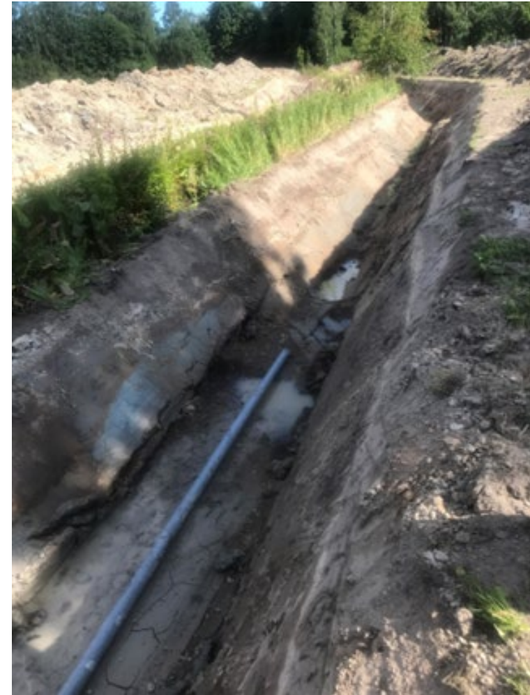
Kuva: Putken, 200 m asennus.
