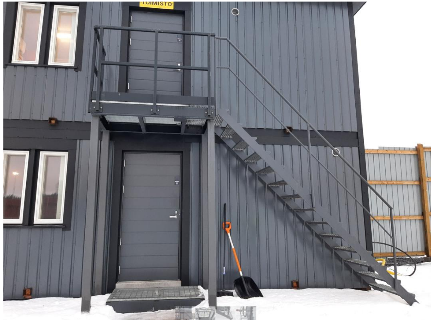
Uudelleenkäytetyt teräsportaat Puijon Romun toimistolla. Kuvalähde: Mikkelin kehitysyhtiö Miksei Oy:n oma arkisto
