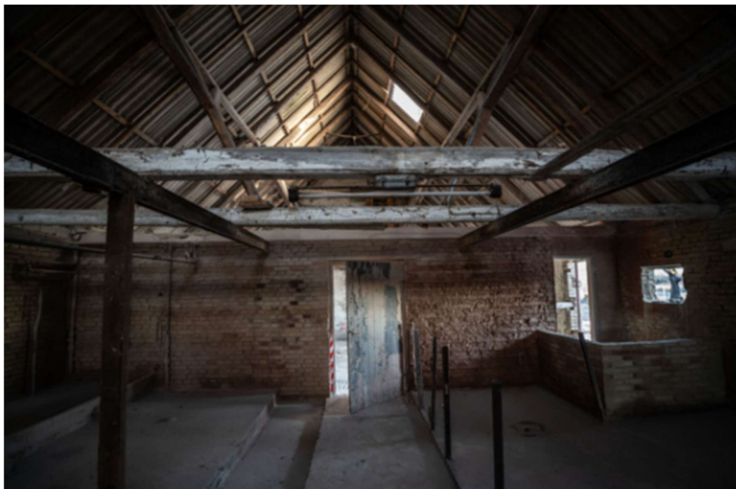
Kuva 24. Säästävästi purettu ja uudelleen rakennettu navetta. (Lendager 2023)
