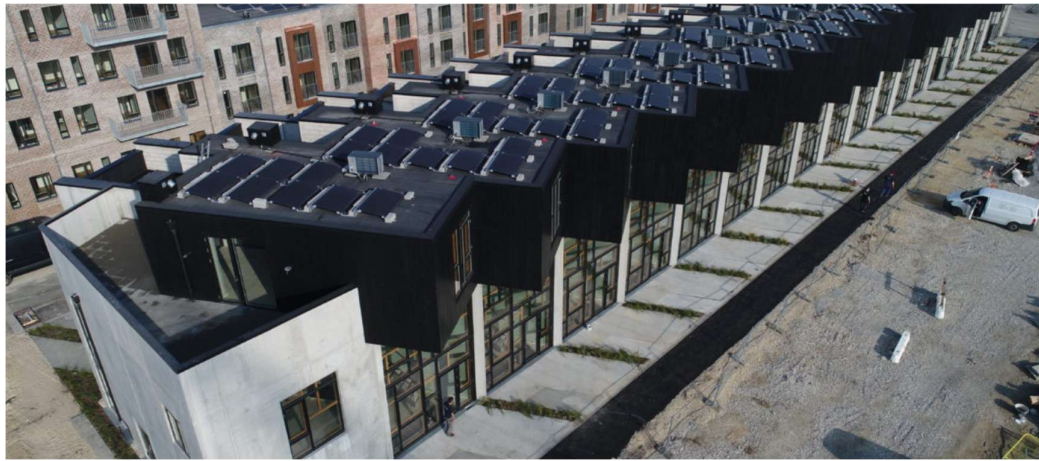
Kuva 4. Kolmikerroksinen rivitalo, Upcycle Studios, Kööpenhaminan Ørestad South -kaupunginosassa. (Palomäki s.a.)
