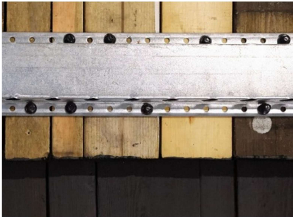
Kuva 20. Aulis Lundell Oy:n tuulettuva ruode, joka on kiinnitetty kierrätettyyn julkisivun puumateriaaliin. (Talo Varjo - Innovatiivinen koti kierrätysmateriaaleista s.a.)
