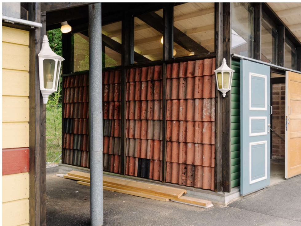
Kuva 3. Seiniin on käytetty myös kierrätettyjä kattotiiliä. (Wennberg 2022; Radar s.a.)
