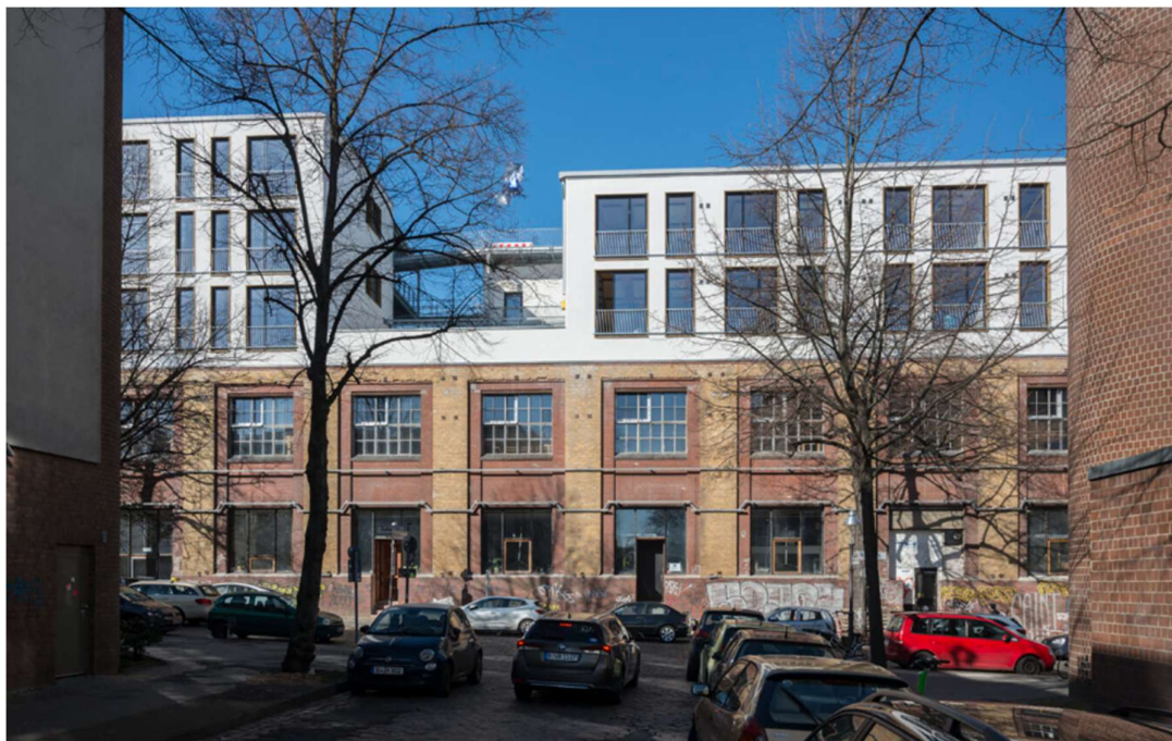
Kuva 17 Entiseen varastoon on lisätty uudet puurunkoiset asuin- ja toimistokerrokset. (Nurmi 2024)
