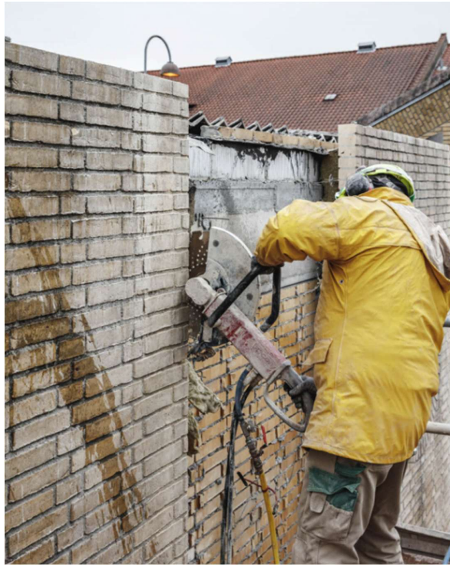
Kuva 9. Tiilimoduuleiden leikkaamista irti panimon seinästä. (Lendager 2019)
