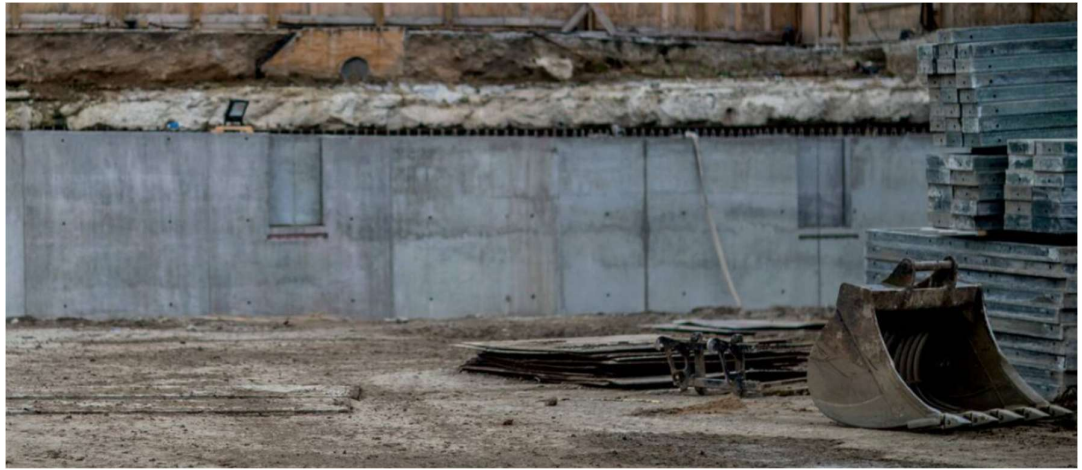
Kuva 22. Keravan Anttilan purkutyömaa. (Sweco 2025)
