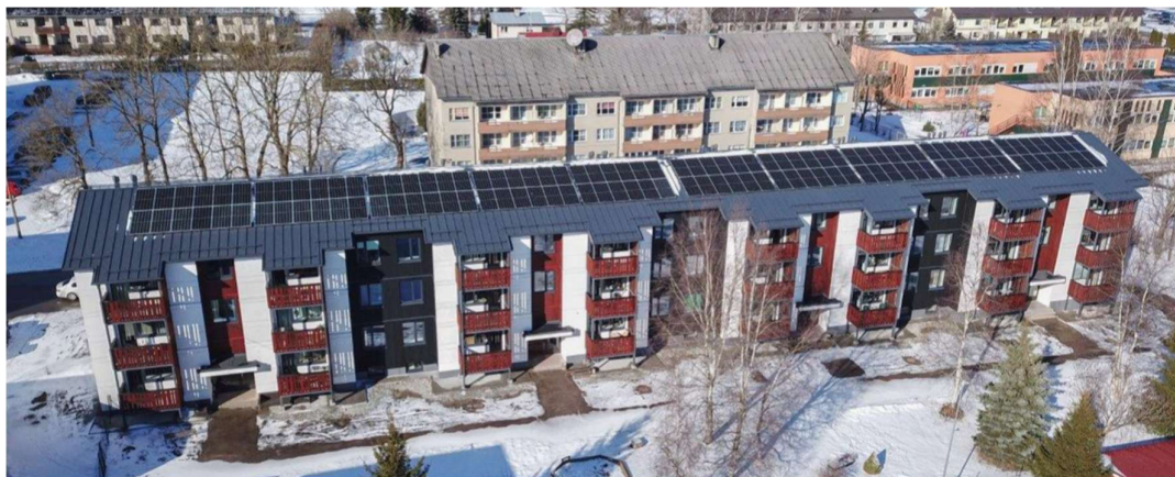
Kuva 13. Pilottihanke kerrostalon peruskorjauksesta kiertotalousperiaatteella. (Timbeco 2021)
