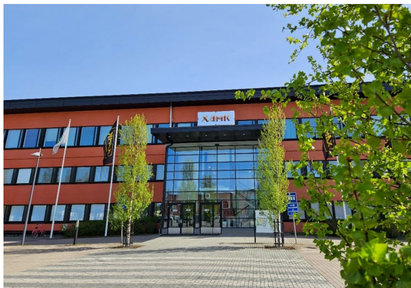
Xamk Mikkeli campus, main building (D) entrance
