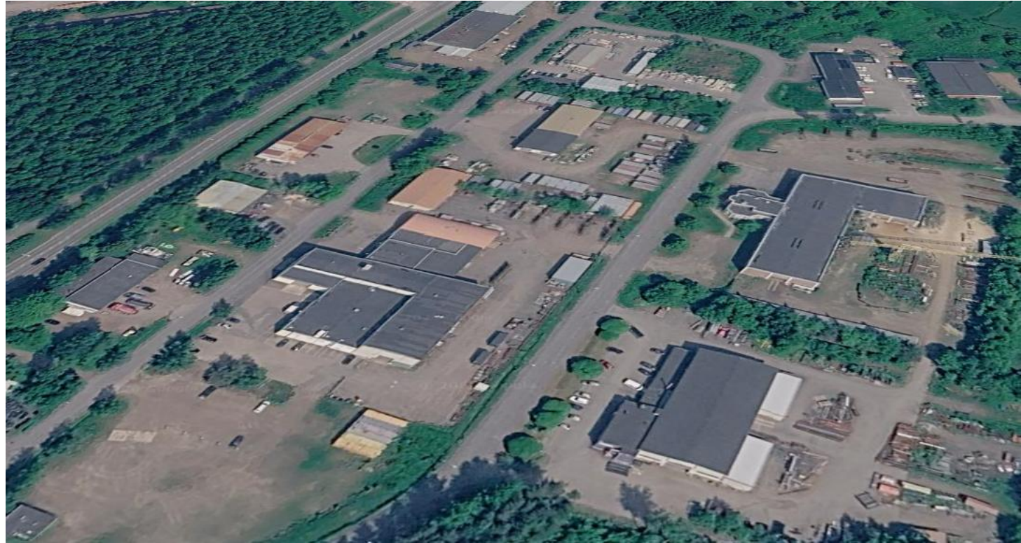
Kuva 1. Ilmakuva Voikkaalla sijaitsevasta teollisuusalueesta
