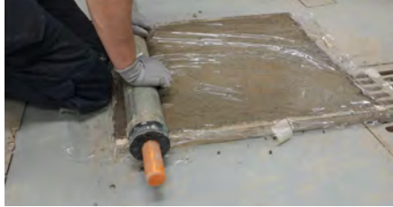
Savilevyn valssaus useasta kerroksesta savi-päistäremassaa. Juuttiverkko alapinnassa ja 3 mm yläpinnasta.
