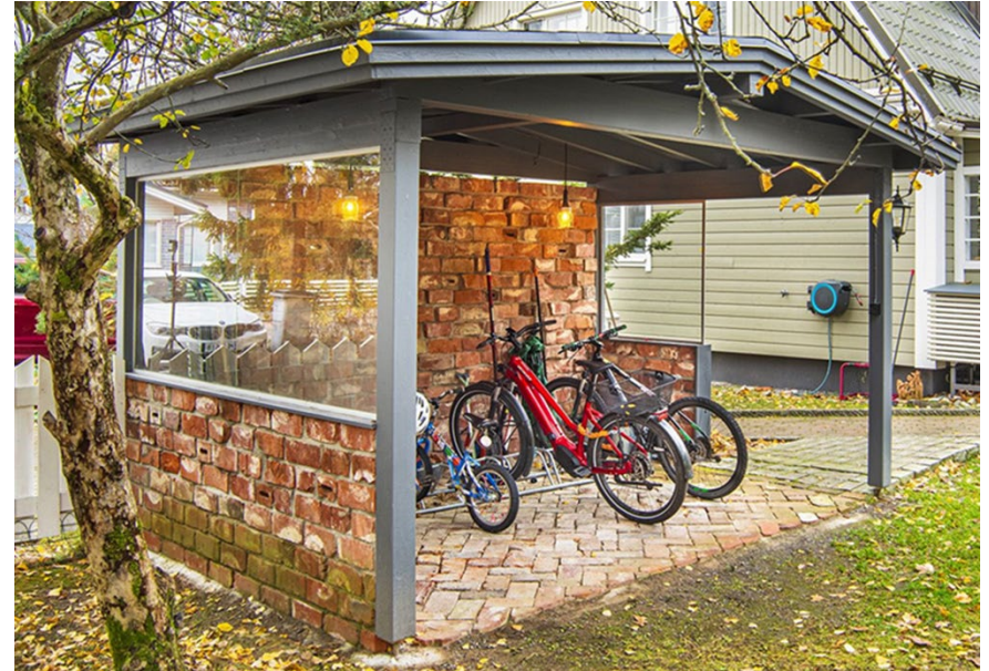
Yksityishenkilön rakentama pyöräkatos hyödyntäen purkutiiliä. Lähde: https://www.rakentaja.fi/artikkelit/20783/pyorakatos_kierratys_tiilista.htm
